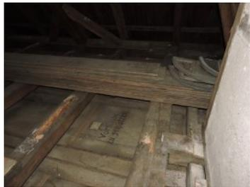
Um den Schaden vollends entdecken zu können, musste der Bretterboden des Dachbodens und die darunter liegende Dämmung entfernt werden. Danach wurde eine Schadenskartierung erstellt.
