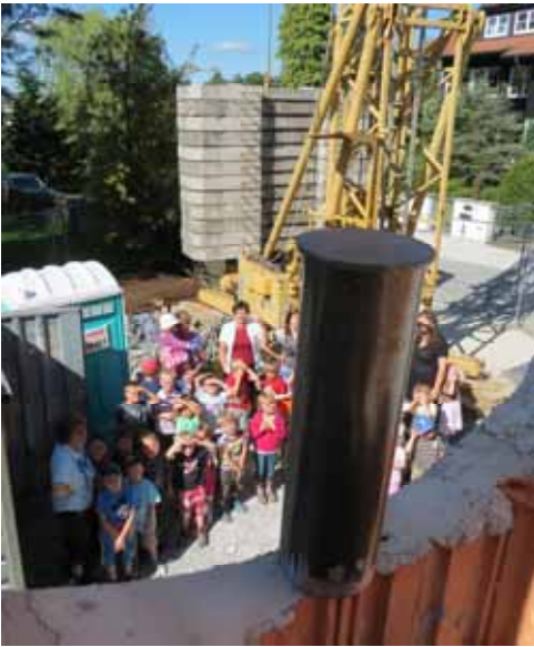
Die Zeitrolle wird ins Mauerwerk eingebettet
