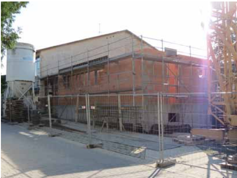
Die Baustelle der Krippe
